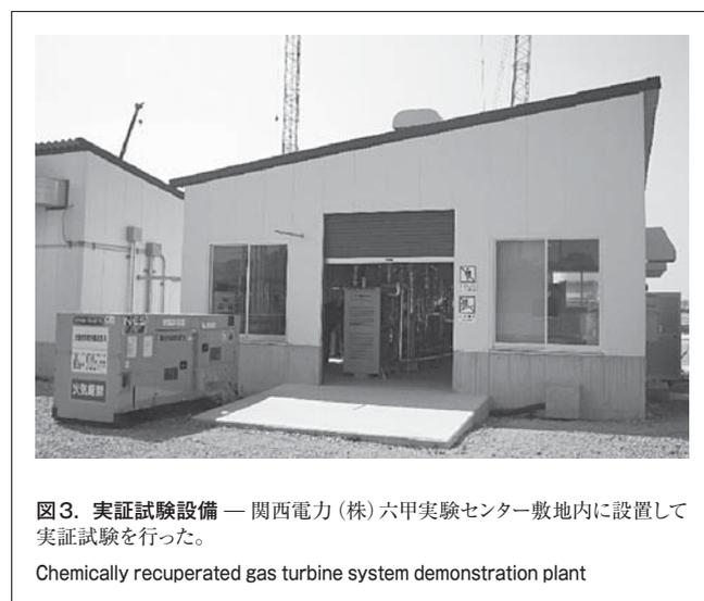
実証試験設備は、出力30 kWのCapstone社製マイクロガスタービン (MGT) を改造し、新たに開発した改質器と燃焼器を組み込み、排熱ボイラなどの機器と組み合わせている。燃料のDMEは、700 kgボンベから液体で取り出し、電気による温水加熱方式の気化器で気化させてから、試験設備に供給した。DME化学再生ガスタービンシステムの実証試験設備の計画仕様を表4に示す。DME改質用の触媒は、触媒試験により選定した白金/アルミナ (Pt/Al<sub>2</sub>O<sub>3</sub>) 触媒を使用し、不活性のアルミナ球と混合して改質器に充てんした。このシステムでは、水蒸気とDMEのモル比率 (S/DME) を3.5に設定し改質器に供給した。
