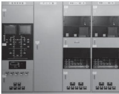
図3. 変電所配電盤システム — 配電盤は、左から監視制御盤、PLC盤 (TCRを収納)、保護リレー盤1系、及び保護リレー盤2系で構成している。
