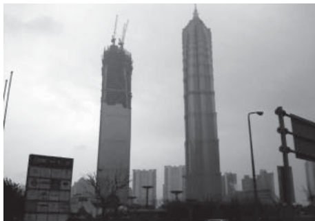
図1. 上海ヒルズ— 上海ヒルズには、階間調整機能付きダブルデッキエレベーターのほか、速度600 m/minの高速エレベーターが据え付けられる。
