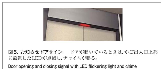
赤く点滅する発光ダイオード(LED)の表示灯をかご出入口上部に設置した(図5)。かごあるいは乗り場の利用者から見えやすく、かつ混雑時でも見える位置とした。また、視覚障害者の利用も考慮して、チャイム音を鳴動させ、光と音の両方で注意喚起するようにした。
