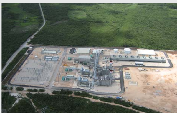
▲ バジャドリッドⅢ発電所全景 Valladolid III Power Plant
