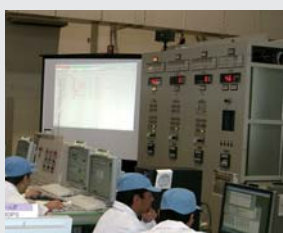
▲ Super Stage Test (東芝制御装置とGE制御装置の総合組合せ試験) Super Stage Test
