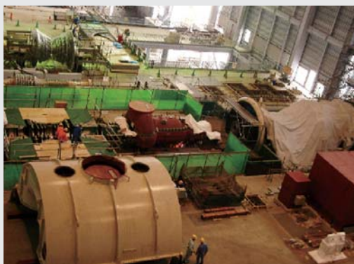
▲ パワートレイン据付け全景 Installation work of power-train
