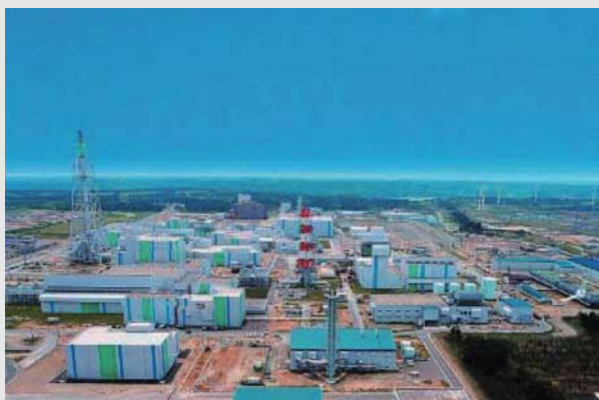
▲ 六ヶ所再処理施設の全景 Rokkasho Reprocessing Plant
