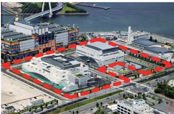
大阪PCB廃棄物処理施設の全景 Osaka PCB Waste Disposal Facility
