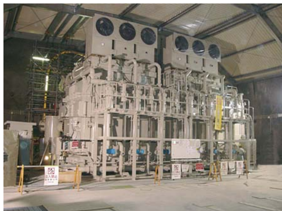
据付け工事中の九州電力(株)小丸川発電所向け 710 MVA 主要変圧器 Installation of 710 MVA main transformer for Omarugawa Power Station of Kyushu Electric Power Co., Inc.
