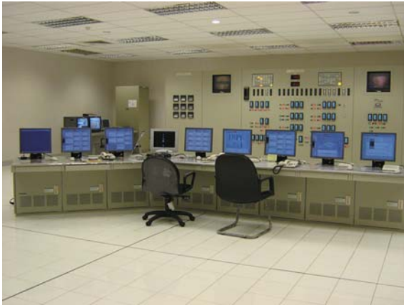
タンジュンジャチB火力発電所向け TOSMAP-DS™のオペレーターステーション
