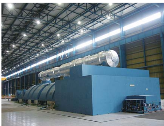
タンジュンジャチB火力発電所710 MWタービン発電機 710 MW steam turbine and generator set for Tanjung Jati B Power Plant, Indonesia
