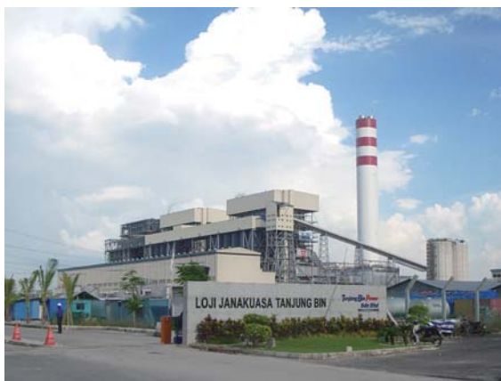
タンジュンビン発電所 Tanjung Bin 3 x 700 MW coal-fired power plant, Malaysia
