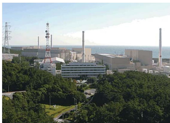
中部電力(株)浜岡原子力発電所
