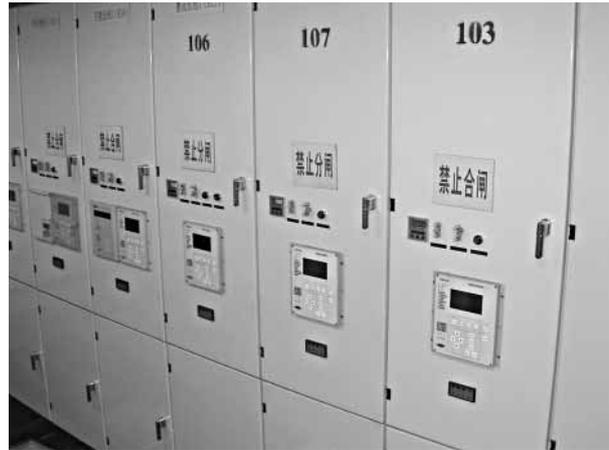
図7. C-GIS盤に設置されたFMR — C-GIS盤の前面にFMRが設置されている。
