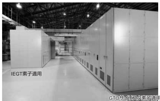
図8. IEGT 素子適用による電力変換器の小型化 — 従来の GTO サイリスタ素子適用の電力変換器と比較して、IEGT 素子適用の電力変換器では外形1/2の小型化を達成した。
