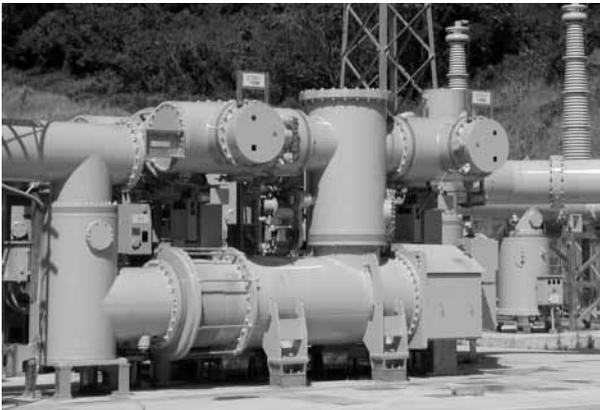
図4. 据付完了後の300 kV GIS — 遮断器を横置き・低層配置とすることにより、GIS全体の低層化、耐震性の向上、及び保守点検性の向上を実現した。
