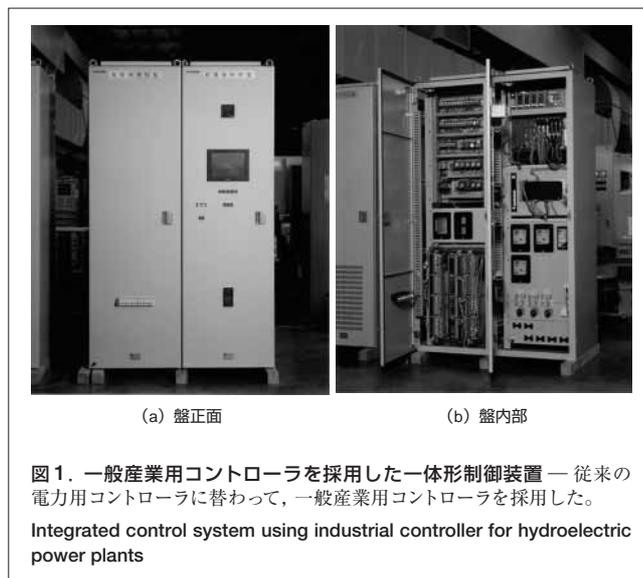
図1. 一般産業用コントローラを採用した一体形制御装置 — 従来の電力用コントローラに替わって、一般産業用コントローラを採用した。
