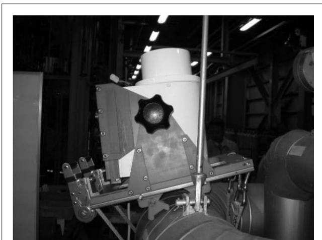
図3. 配管への取付け状況 — 専用治具を用いて、4インチカラーI.I. TM を保温付き配管に取り付けている。 4-inch color image intensifier fixed on insulated pipe
