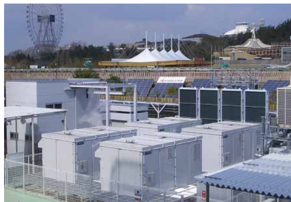
愛知万博会場で運転された4台のりん酸形燃料電池 Four phosphoric acid fuel cell units operated at Aichi Expo site
