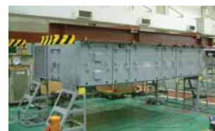
補助電源装置
