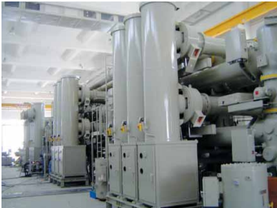
アブダビ ウマルナル IWPP 発電所併設変電所における 400 kV GIS の現地試験状況 Site test of 400 kV gas-insulated switchgear (GIS) at Abu Dhabi Umm Al Nar IWPP Substation
