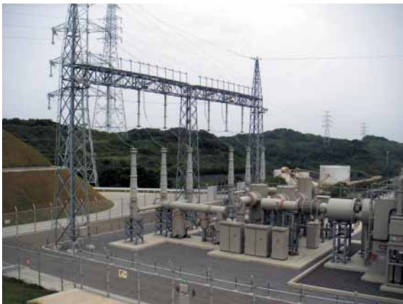
九州電力 (株) 松島変電所向け 240 kV GIS 240 kV GIS for Matsushima Substation of Kyushu Electric Power Co., Inc.
