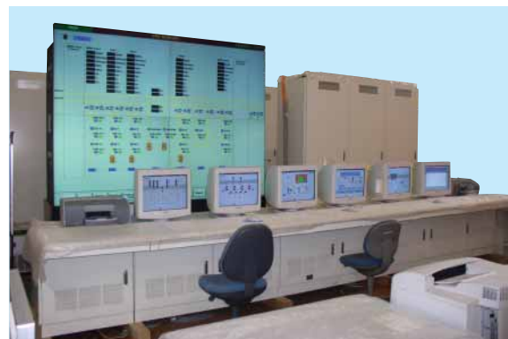
ティースタ水力発電所向け分散監視制御システム Distributed information and control system for Teesta hydroelectric power plant
