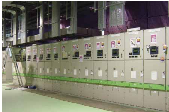
マレーシア タンジュンビン火力発電所向け MV スイッチギヤ Medium-voltage metal-clad switchgear for Tanjung Bin Power Plant, Malaysia
