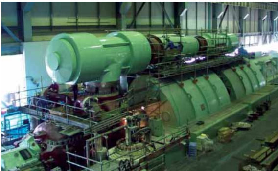
九州電力(株)新小倉発電所向け 500 MW タンデムコンパウンド機のパワートレイン 500 MW tandem compound machine power train for Shin-Kokura Thermal Power Plant of Kyushu Electric Power Co., Inc.
