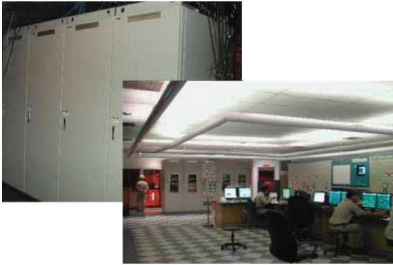
タービン発電機のデジタル制御システムの据付け状況 Digital control system for steam turbine-generator
