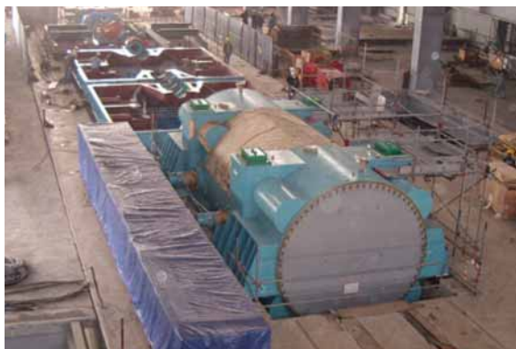
オンベースを完了した934 MVAタービン発電機 934 MVA turbine-generator installed at site
