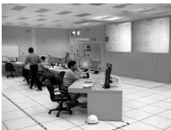
図1. Chiahui中央制御室 — 大型スクリーン及びHMIによる集中監視・制御を実現し、運転員への負荷低減を実現している。
