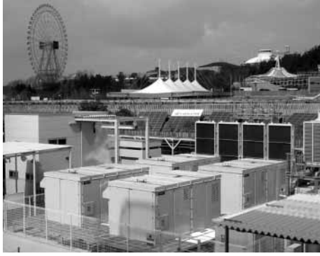
図6. 万博会場で運転中のPAFC — 愛知万博会場内に設置された4台のPAFCは、マイクログリッドの電圧基準となる。
