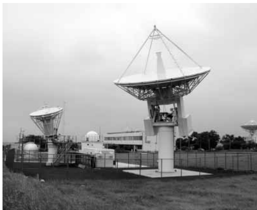
直径 11 m 及び 5 m のパラボラアンテナなどの施設
