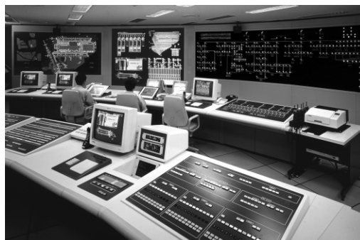
図6. 監視室 — 航空灯火施設と電力施設を総括管理する。 Control room
