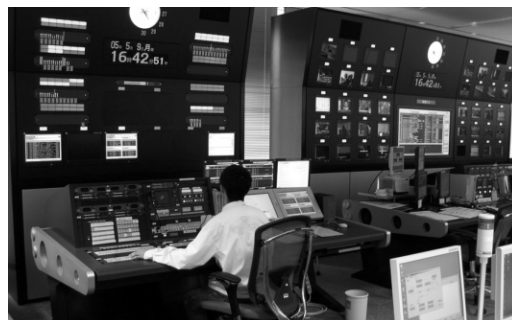
図3. 放送センターの内部 — 最大映像9チャンネル、音声60チャンネルの放送番組を監視できる。
