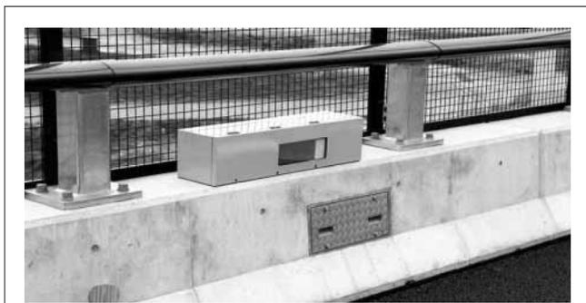
図2. 照明器具の外観—路肩側の壁高欄上に器具を設置した。
