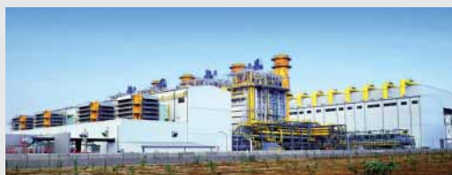
◀ 豊徳発電所 外観 Fong-Der Power Station, Taiwan
