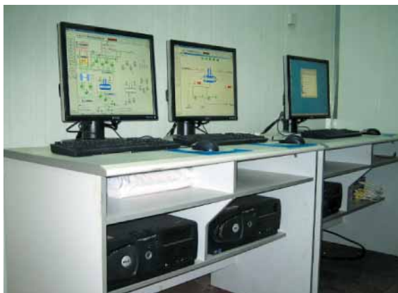
中国向け火力発電プラント用 DCS の監視制御用端末 Human-machine interface of distributed control system for thermal power plant in China
