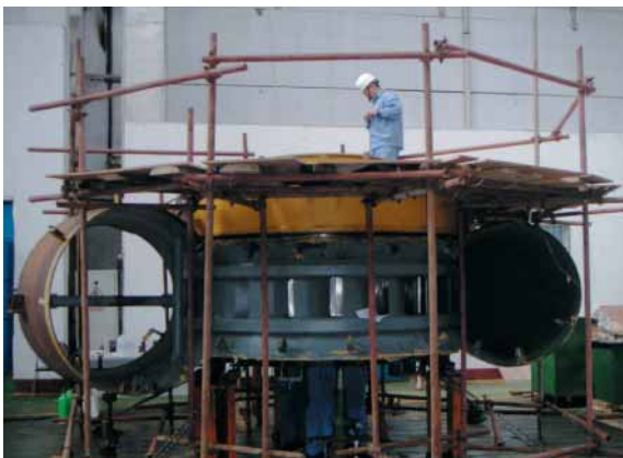
北海道電力(株) 江卸発電所向け 水車本体静止部の工場組立 Turbine shop assembly for Eoroshi Power Station of Hokkaido Electric Power Co., Inc.
