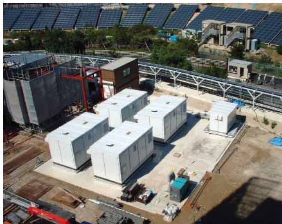
愛知万博会場に設置されたりん酸形燃料電池システム
