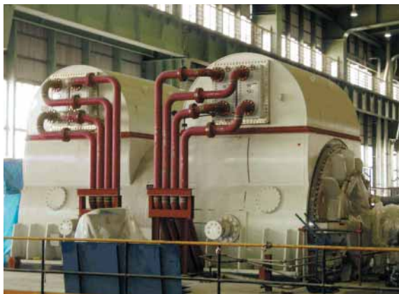
据付けを完了した発電機 410 MVA hydrogen-cooled Generator installed at site
