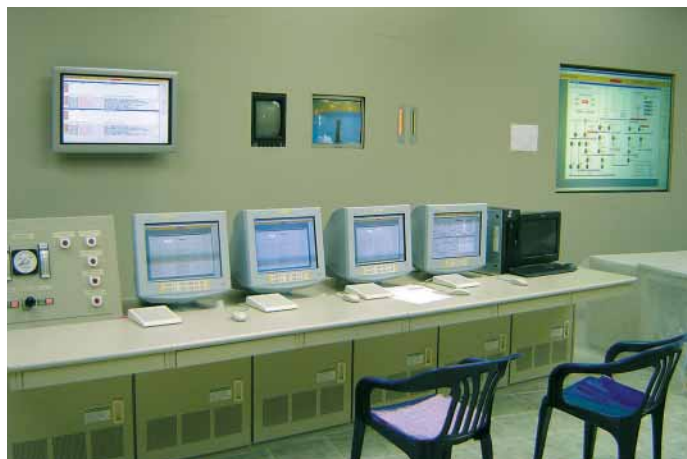
ベネズエラ AMPLIACION TACOA 火力発電所 9号機の新中央 操作室 New central control room for Unit No. 9 of AMPLIACION TACOA Thermal Power Plant, Venezuela
