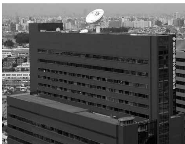
図1. 大井町放送センター — 屋上にアップリンク用の直径7.6 mのメインアンテナ(中央)とバックアップアンテナ、及びモニタ用のSバンド受信アンテナを設置している。放送センターはこのビル内にある。 Oimachi Broadcasting Center (situated in this building)
