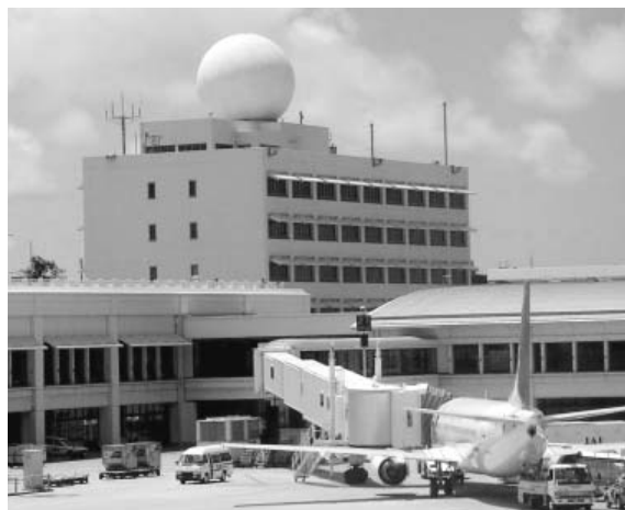
図1. 那覇空港で運用を開始した空港気象ドップラーレーダー正面の那覇空港統合庁舎の建屋屋上に見えるドームが那覇空港気象ドップラーレーダのレドームである。その下の那覇航空測候所の機器室に構成装置が設置されている。
