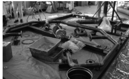
図8. モックアップ配管の外観 — 揚水発電所の埋設配管を模擬したモックアップモデルを製作して、ライニング施工方法を改良した。 Appearance of mock-up piping
