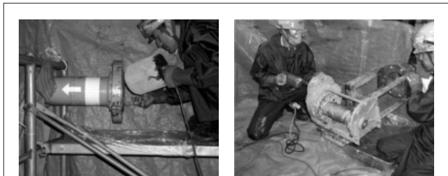
図11. 配管ライニング施工状況 — 埋設配管の露出フランジ部からピグを挿入して、ワイヤでけん引している。 Views of pipe lining construction
