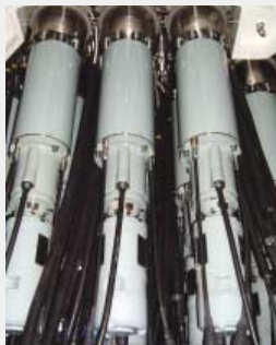
改良型制御棒駆動機構(シールレス型)構造図 Configuration of S-FMCRD
