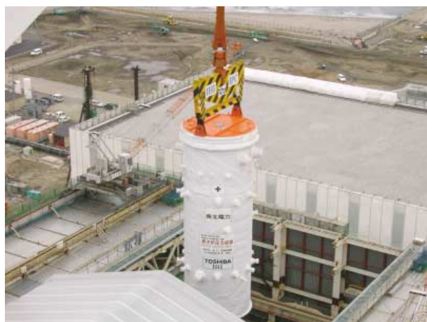
東北電力（株）東通原子力発電所 1号機 原子炉圧力容器の据付け Reactor pressure vessel on base at Higashidori Nuclear Power Station Unit No. 1 of Tohoku Electric Power Co., Inc. (1,100 MWe, BWR)
