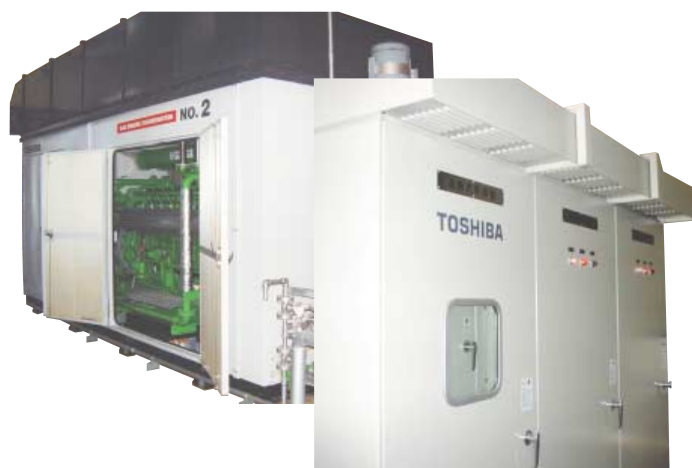
ガスエンジン コージェネレーションシステム Gas engine cogeneration system
