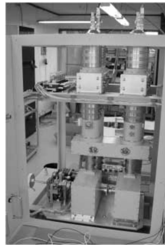
図6 . 無停波切替器 - 無停波切替器の内部で,最下部が誘電体可変移相器である。 Crossover exchanger
