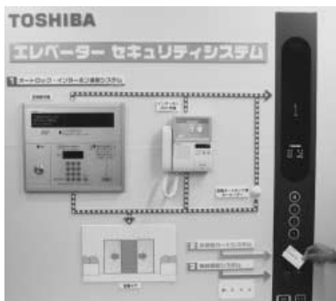
図3 . エレベーターセキュリティシステム - マンションなどのオートロック、インタホンとエレベーターを連動させたり、非接触カードや指紋認証により呼び登録を許可するセキュリティ機能を提供する。
