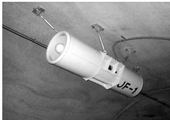
図3. ジェットファン据付状況 - トンネル上部につり金具を用いジェットファンを固定している。
