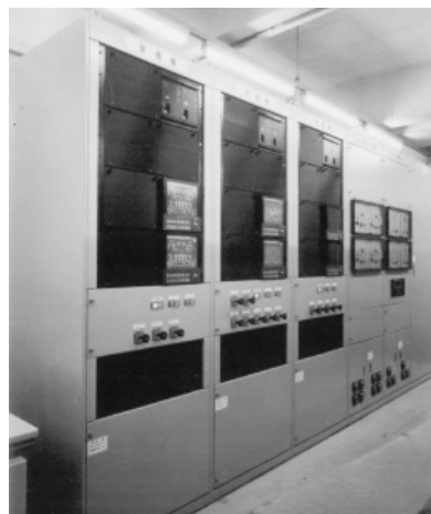
図5. ME型配電盤 - 保護、連動、監視、計測及び保全データ収集機能を同一のデジタル処理装置で実現した最新ME型配電盤の外観を示す。 Microelectronic type switchboard
