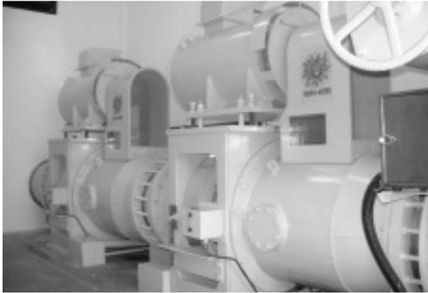
図4 . 直列 Hydro-e KIDS™ M型 - インドネシアのオルジヨダムに納入した2台直列方式による設置例を示す。2台の水車で有効落差を分担し高落差対応している。
