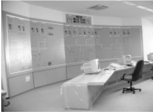
図7. ベトナム ハムツアン発電所向け 監視制御システム - 主制御室から2か所の発電設備,送電線開閉機器,ダム設備などの総合監視制御を行う。
