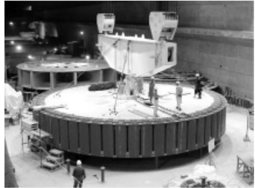
図8. パキスタン ガジバローサ発電所向け 水車発電機 - 固定子径が16 mを超える大直径機である。
