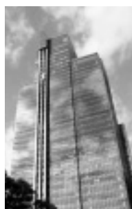
図1 泉ガーデンタワー - 2台の屋外形展望エレベーターが建物壁面に沿って昇降する。
