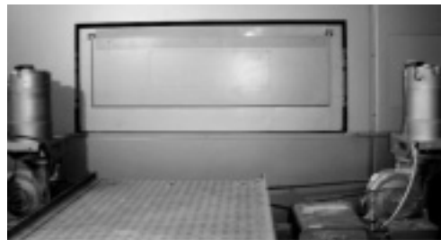
図8 . 落下物防止装置 - 収納した落下物はかご内から安全に回収できる。 Falling object catcher
