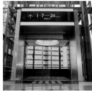
図9. シャトルエレベーターかご - 大型ガラスを多用した展望かごである。
