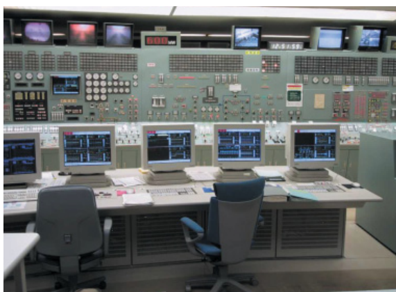
更新後の全自動化監視・制御システム操作卓 Automatic control system operation desk
