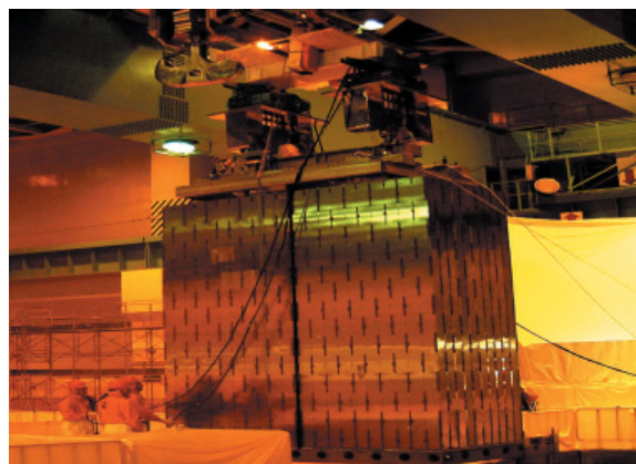
高密度使用済み燃料ラックの燃料プールへの据付け Installation of high-density spent fuel rack in spent fuel pool
