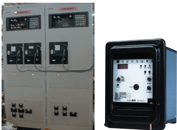
D -S形適用デジタル保護リレー - 盤(左)とV形単機能デジタルリレー(右) DIII-S numerical relay panel (left) and V series relay (right)
