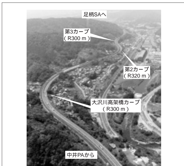
図2. 東名・大沢川地区 - 高スピードで連続カーブに進入しやすい地点であり,事故が多発している。
