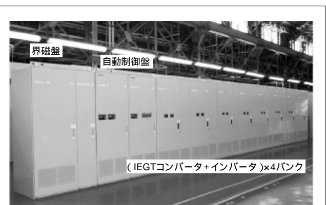
図3 . 大容量 IEGT インバータ装置 - 4バンク構成で、大容量鉄鋼圧延主機駆動にも適用した。
