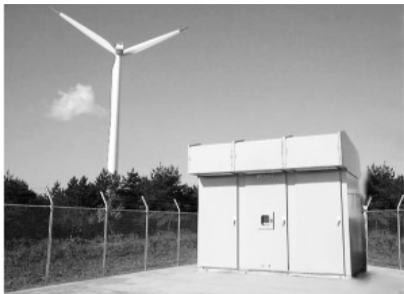
図7. 風力用自励式 SVCS™ - 風力発電に SVCS™ を適用した例を示す。 Self-commutated SVCS™ for wind power plant
