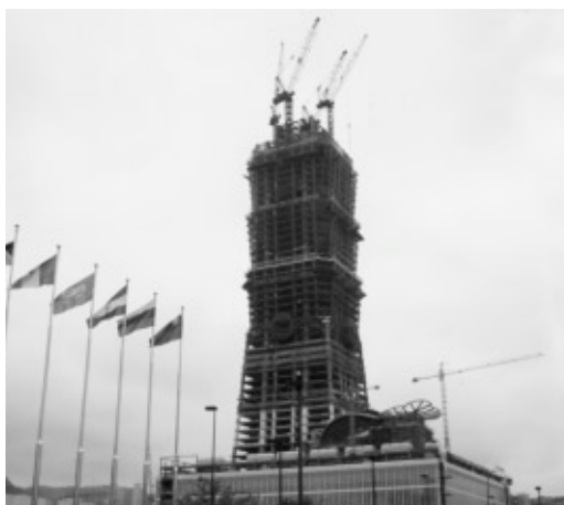
図1．台北国際金融センター - 建設工事が進んでいる台北国際金融センター。
