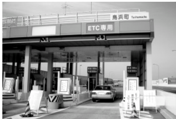
図3．均一料金制のETCシステム - “ETC専用”運用中の首都高速道路公園の料金所。 Open ETC system
