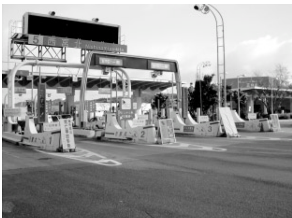
図2．対距離料金制のETCシステム - “ETC混在”運用中の日本道路公団の入口料金所。 Closed ETC system
