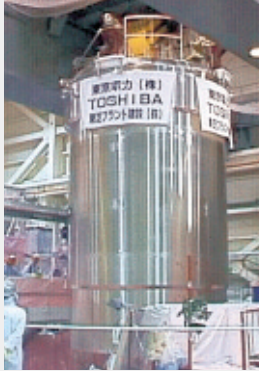
炉心シュラウドの原子炉内への吊込み Installation of core shroud into vessel
