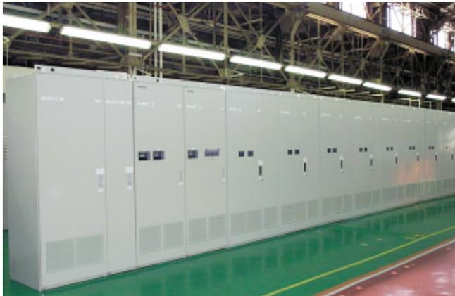
17,000 kW電動機用 IEGT 3レベルインバータ TOSVERT<sub>TM</sub>- $\mu$ /S650W
