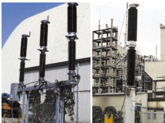
145kV碍子型ガス遮断器(左)と245kV碍子型ガス遮断器(右)
