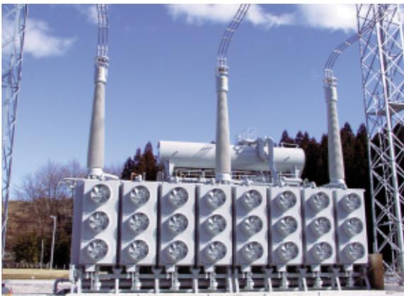
東京電力(株)新榛名変電所向け525 kV - 670 MVA ASA 変圧器
