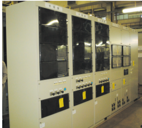
山陽新幹線向け ME統合システム Integrated microelectronics system of Sanyo Shinkansen
