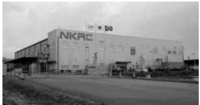
図1.家電リサイクル工場の外観 品目ごとの処理ラインを備え、約50万台/年の処理能力を持っている。
